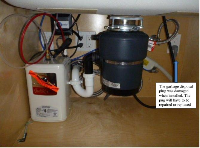
THE GARBAGE DISPOSAL PLUG WAS DAMAGED AND NOT OPERABLE AT THE TIME OF THE INSPECTION PLEASE HAVE THE BUILDER REPAIR THE PLUG AND SHOW YOU IT IS OPERATING AT THE TIME OF THE WALK THROUGH.
