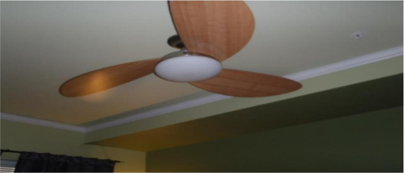
**THE BEDROOM CEILING FAN IS OUT OF BALANCE AT MEDIUM TO HIGH SPEEDS, COMPLETE ANY AND ALL REPAIRS FOUND TO BE REQUIRED TO ENSURE PROPER AND SAFE OPERATION.**
